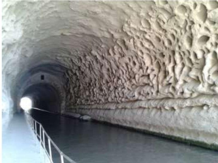
Figure 5 : Vue du tunnel du Malpas, ouvrage de franchissement du Canal du Midi creusé sous la colline d'Ensérune (Photo : L. Izac)
